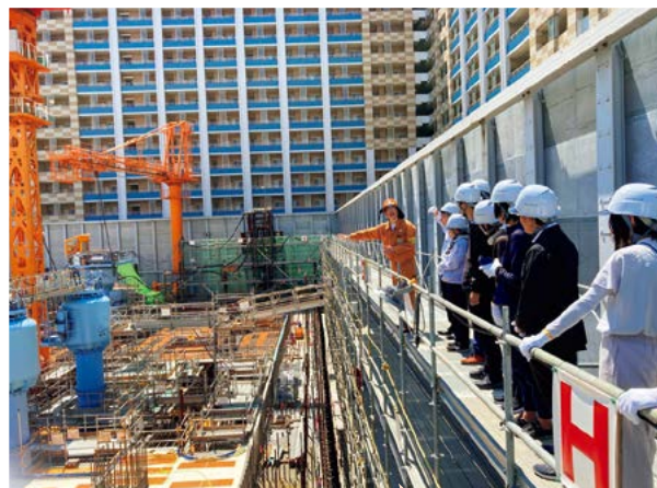
勝どきポンプ所 現場見学 (大林組)
